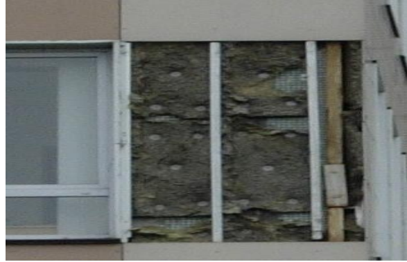
Рис.1. Фрагмент вентилируемого фасада – разрушение и выветривание минераловатного утеплителя
