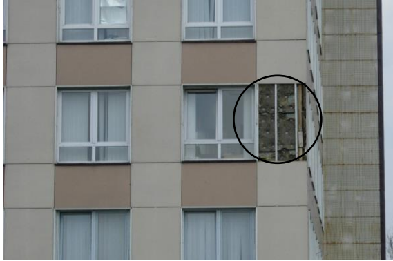
Рис.1. Фрагмент вентилируемого фасада – разрушение и выветривание минераловатного утеплителя
