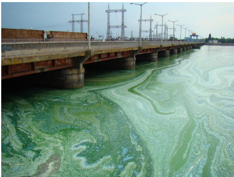
Рис. 1. Світлина водойми поблизу греблі Кременчуцької ГЕС, забрудненої синьо-зеленими водоростями [2]
