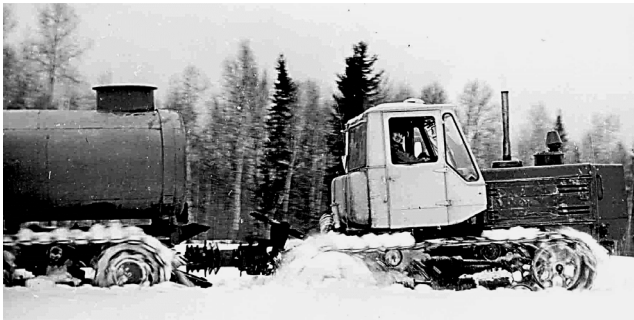
Рис. 6. Рух гусеничного повноприводного транспортного машинно-тракторного агрегату з механічною трансмісією для передачі потужності на технологічний модуль
