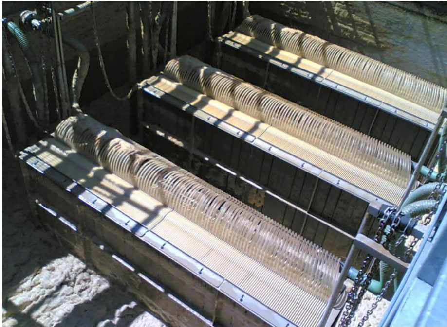
Рис. 3. Ультрафільтраційний мембранний модуль
