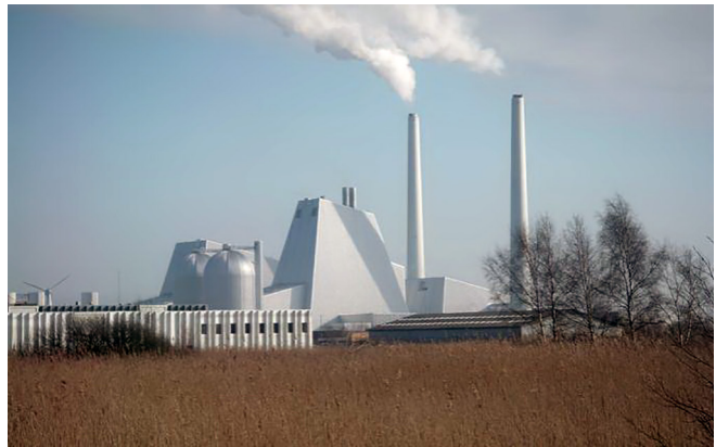
Рис.1. Загальний вигляд вугільної електростанції, переведеної на використання біомаси у м. Аведор, Данія [9, с. 8].
