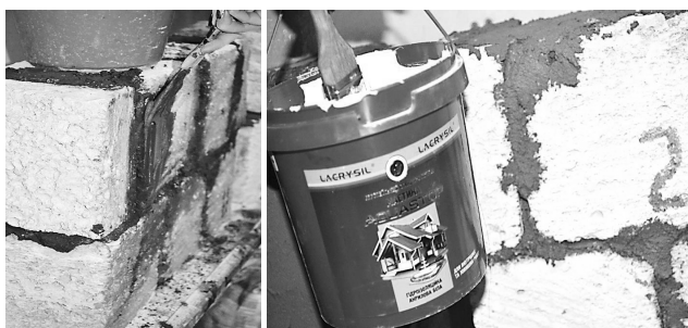
Рис. 2. Рабочий фрагмент нанесения составов гидроизоляции
