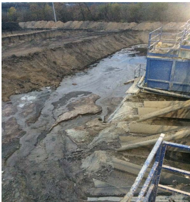
Рис. 3. Вигляд шламового амбару, в який скидаються рідкі відходи буріння
