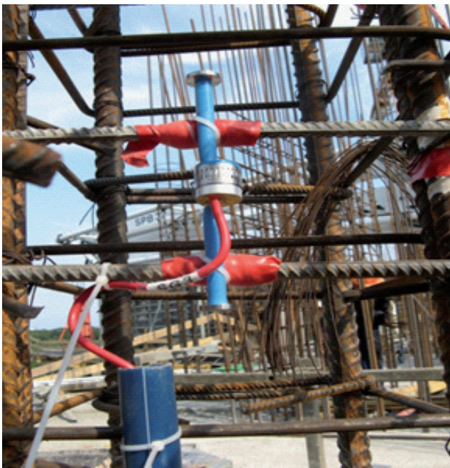
Рис. 4 Датчик относительных линейных деформаций, установленный на арматуре опоры.
