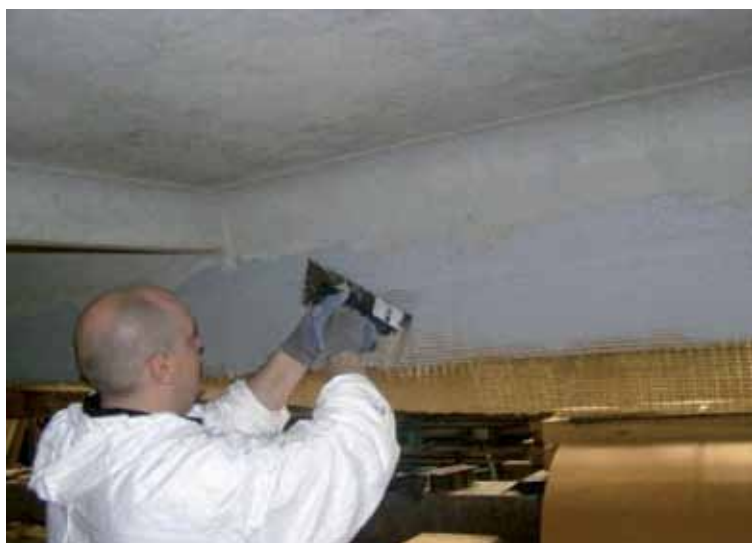
Рис.3. Нанесення підсилюючої сітки Ruredil.
