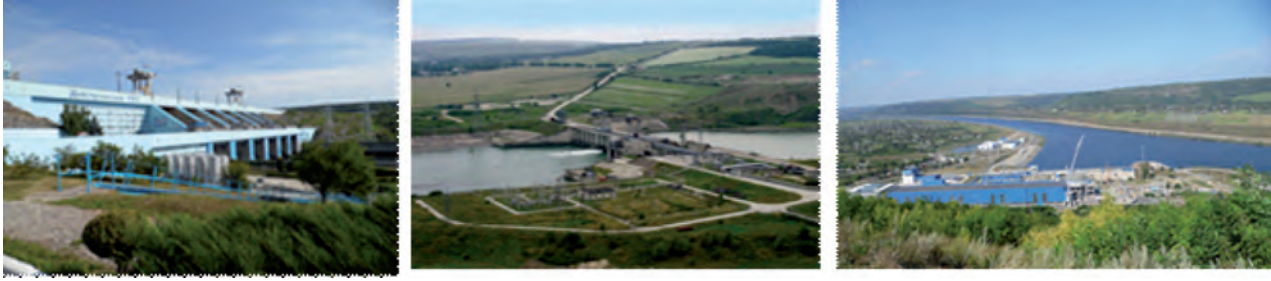
Рисунок 7 – Загальні види на ГЕС та ГАЕС Дністровського каскаду: Дністровська ГЕС; буферне водосховище Дністровської ГЕС (ГЕС-2); Дністровська ГАЕС
