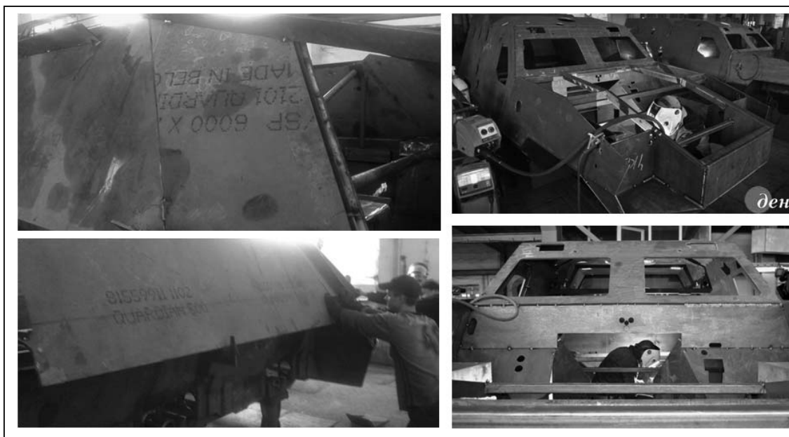
Рис. 9. Приклади низького рівня організації складально-зварювальних робіт корпусів БМ через брак спеціалізованого устаткування для складання та переміщення зварюваних конструкцій
