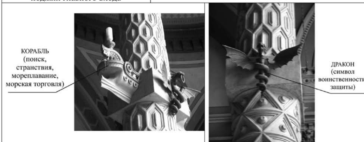
Рис. 5.3. Деталь 2 ростральной колонны
