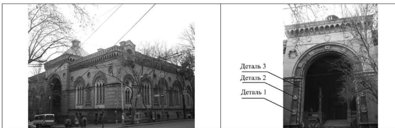
Рис. 3.1. Арка главного входа
