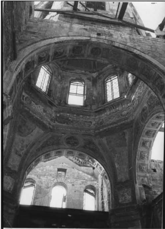
Рис. 12. Госпитальная церковь. Внутренний вид Колокольни. 1989 г.
