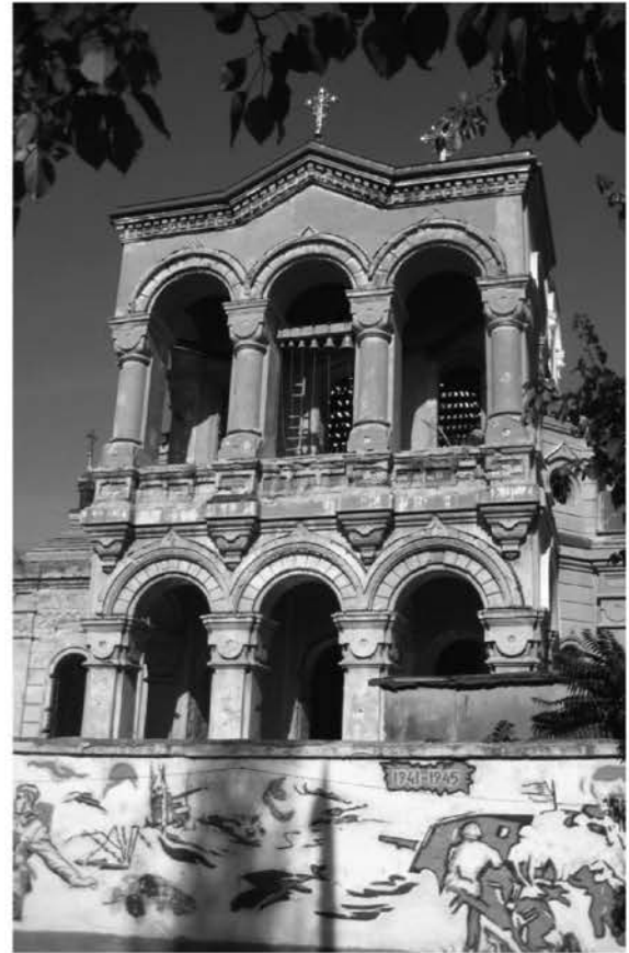
Рис.13. Госпитальная церковь. Западный фасад, колокольня. Фото И. В. Гамзы, 2010 г.
