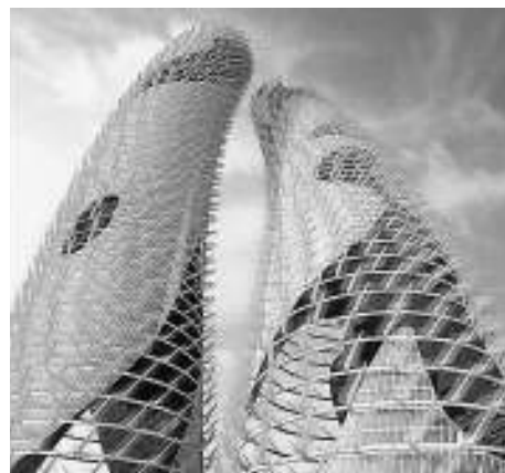
Рис. 12. Gullwing Twin Wind Towers (Дубай, ОАЭ)
