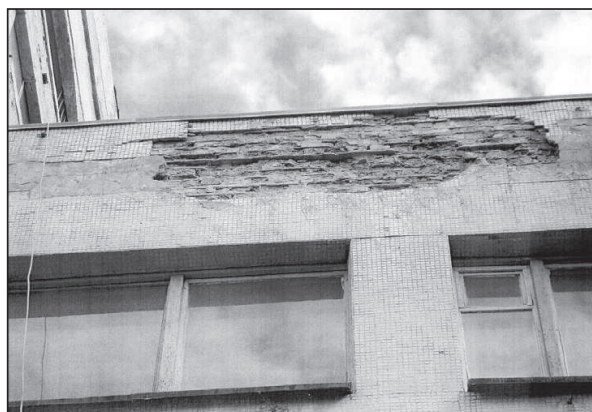
Рисунок 8. Торцевий фасад з вул.Б.Хмельницького
