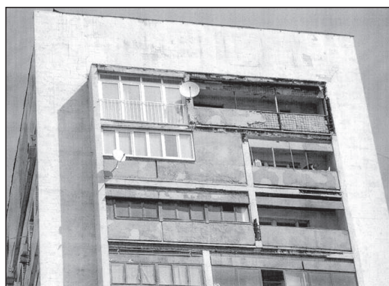
Рисунок 7. Торцевий фасад з вул.Б.Хмельницького
