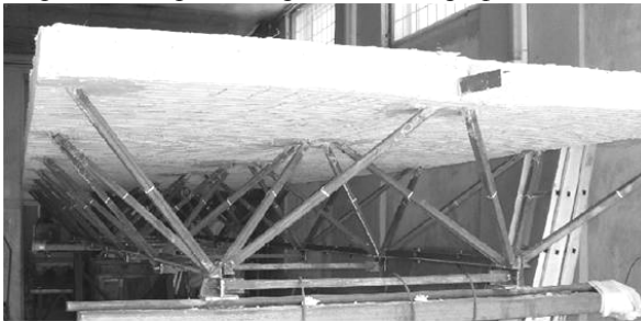
Рис. 2. Загальний вигляд побудованої конструкції прольотної будови
