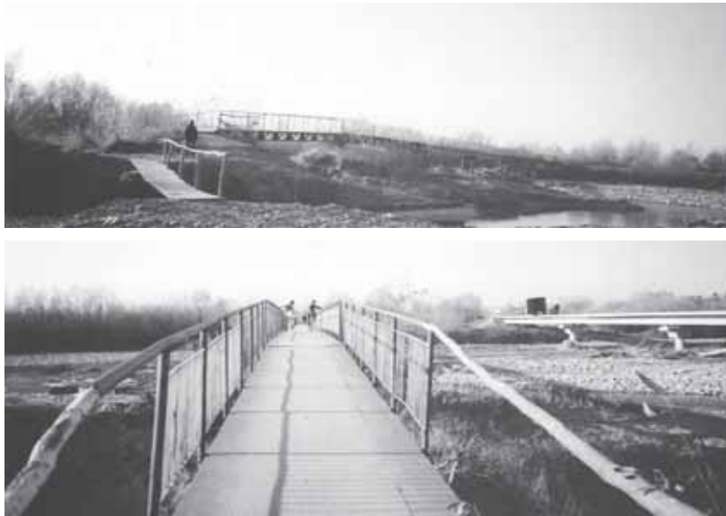
Рис. 1. Загальний вид існуючого моста
