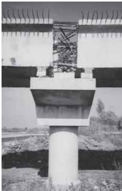
Рис. 3. Проміжна опора з обпертими на тимчасові дерев'яні бруски балками суміжних прольотів і прямими і відігнутими випусками арматури з торців балок
