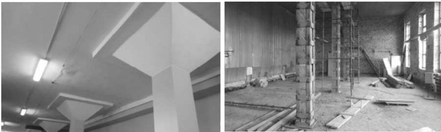
Рис. 1. Загальний вигляд монолітного безбалкового перекриття консервного цеху Куп'янського молочноконсервного комбінату
