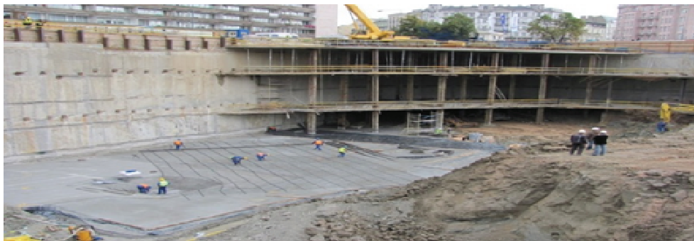
Fot.3. Wykop zabezpieczony ścianami szczelinowymi [12]
