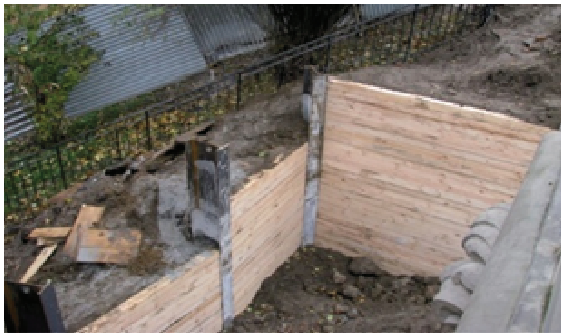
Fot.1. Naroże ścianki berlińskiej [11] Fot.2. Ścianka szczelna typu Larssena [11]
