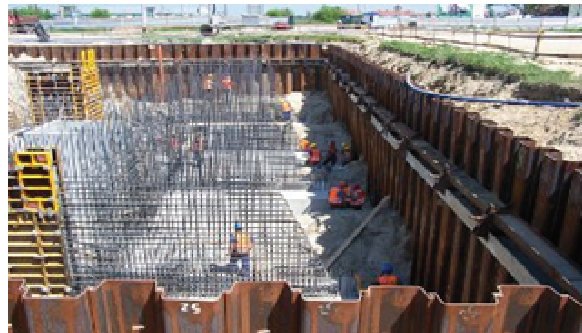
Fot.1. Naroże ścianki berlińskiej [11] Fot.2. Ścianka szczelna typu Larssena [11]
