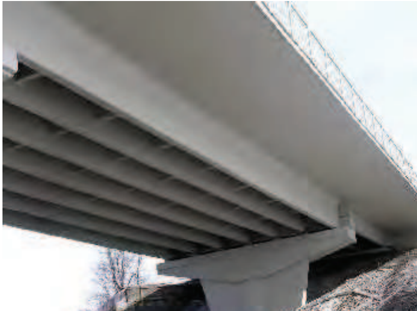
Рис. 3. Вид знизу на розширену монолітною залізобетонною плитою прольотну будову шляхопроводу через залізницю в с. Вістова Івано-Франківської обл.
