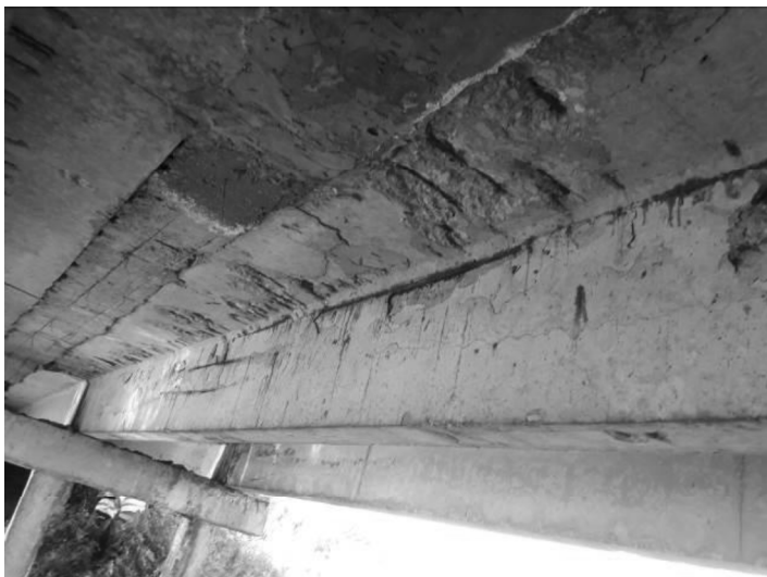
Фото 1. Прогонні конструкції моста
