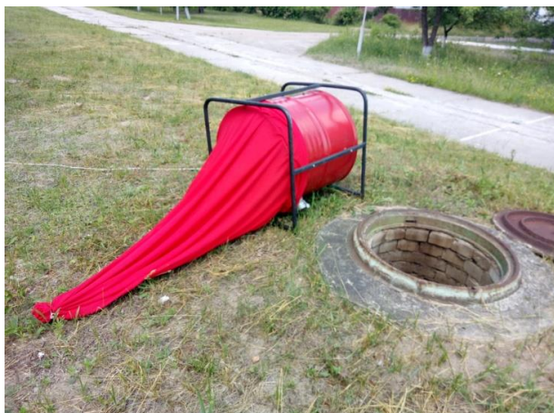
Рисунок 7– Приклади встановлення функціональних моделей генераторів піни високої кратності
