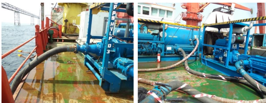
Рис. 3. Гнучкі трубопроводи для подачі хімічних промивних реагентів з судна на платформу
