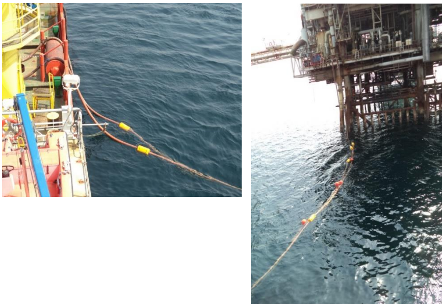
Рис. 2. Гнучкі трубопроводи для подачі стисненого повітря з судна на платформу
