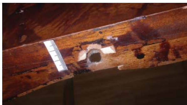
Мал. 3. Наскрізне пошкодження на зовнішній поверхні каркасної планки столешні
