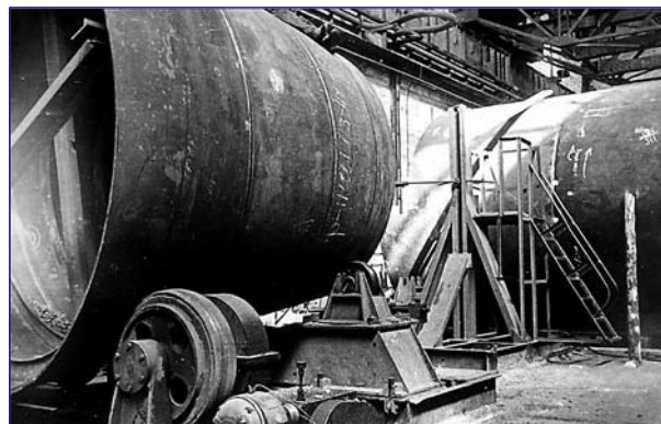
Сварка конических подсеций прочного корпуса ПЛ на кантователе (фото из собрания автора)
