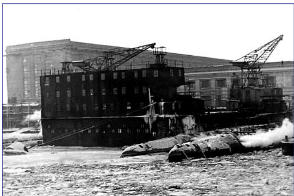
Достройка и швартовые испытания сразу трёх подлодок у борта достроечной плавбазы, ошвартованной у Западной стенки Большого ковша завода № 444, 1953–1954 гг. (фото из собрания автора)
