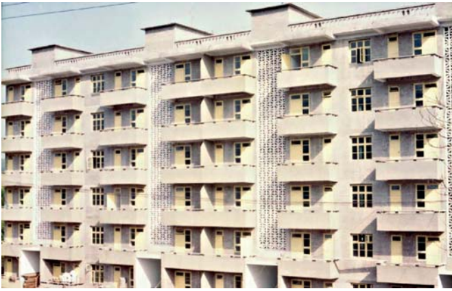
Рис. 6. 1991 р., м. Чуньцінь, КНР. Виробництво та промислове використання панелей переkritтя з шлаколужного бетону
