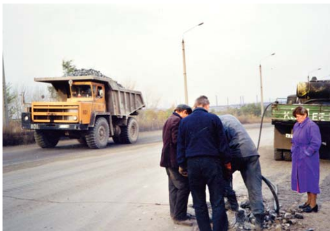
Рис. 4. 1984 г, м. Магнітогорськ, Росія. Спеціальна дорога довжиною 6 км до кар'єру гори Магнітної з монолітного шлаколузного бетону під багатотонажні важкі транспортні засоби (до 60 т).
