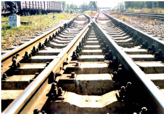
Рис. 3. 1988 р, ст. Чудово, Росія перевідна стрілка залізнична, Санкт-Петербург-Москва. Попередньо напружені шпали та бруски з шлаколузного бетону
