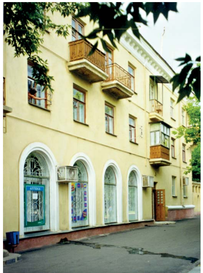
Рис. 2. 1960 р., м. Маріупіль. Житлові будинки (9-15 та 2-4 поверхи), стіни яких зведено з шлаколувних блоків та напівблоків
