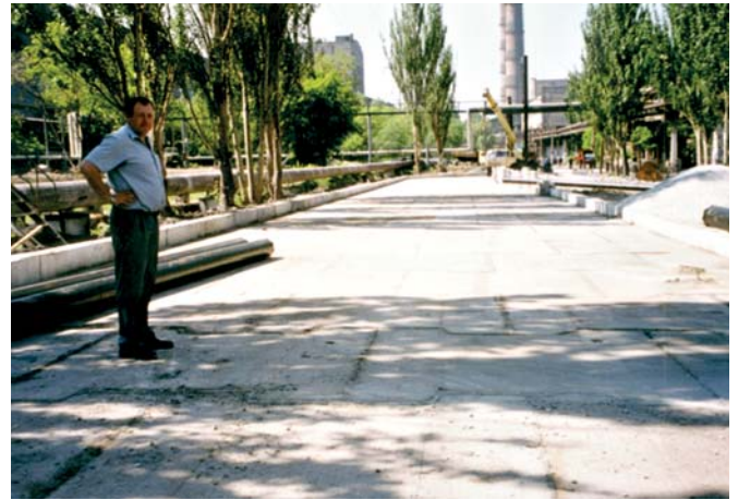
Рис. 8. 1999-2000 р.р. м. Маріупіль, металургійний завод ім. Ілліча. Автомобільні дороги з шлаколужного бетону під багатотонажні важкі транспортні засоби: з монолітного бетону та збірних плит, укладених «в замок».
