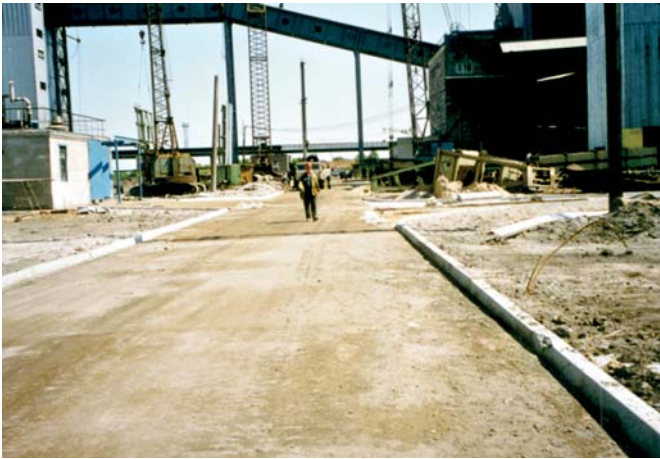
Рис. 8. 1999-2000 р.р. м. Маріупіль, металургійний завод ім. Ілліча. Автомобільні дороги з шлаколужного бетону під багатотонажні важкі транспортні засоби: з монолітного бетону та збірних плит, укладених «в замок».
