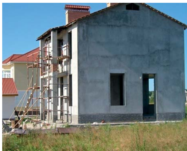
Рис. 1. Жилой двухэтажный дом, возводимый с использованием стеновых газобетонных панелей
