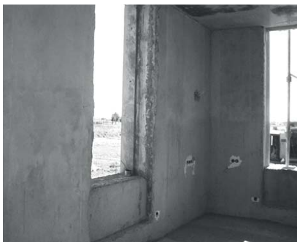
Рис. 2. Фрагмент внутреннего помещения жилого двухэтажного дома возводимого с использованием стеновых газобетонных панелей
