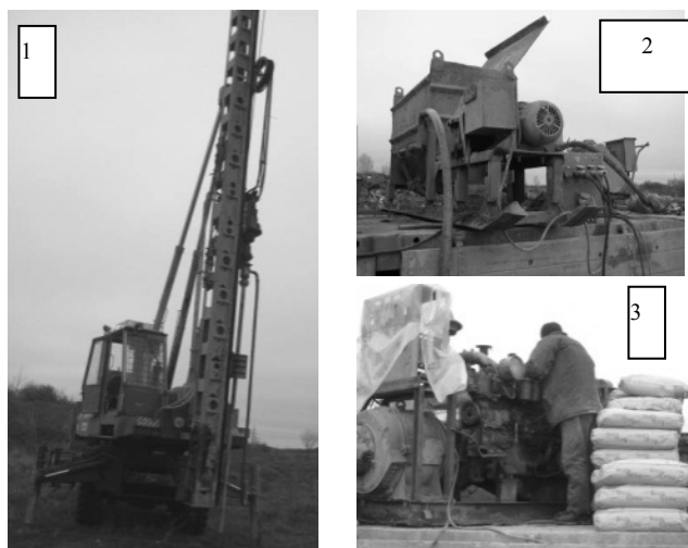
Рис. 2. Обладнання для влаштування ґрунтоцементних елементів (паль) за бурозмішувальною технологією: 1 – бурова машина БМ811м; 2 – розчинозмішувач; 3 – розчинонасос
