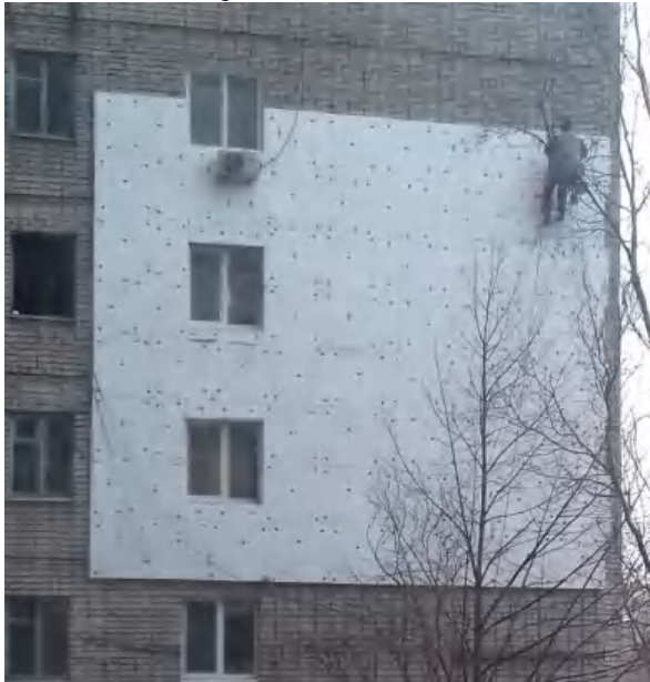
Рис. 4. Утепление фасада / The insulation of facade
