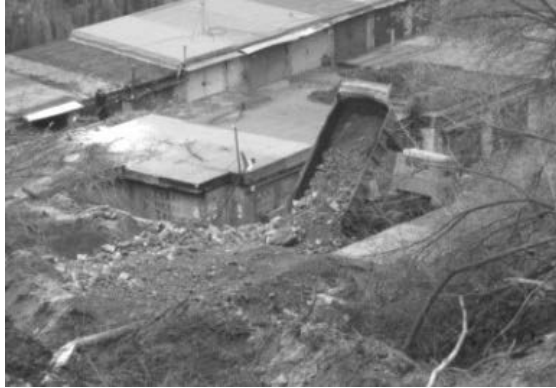
Рис. 5. Привантаження водонасиченого ґрунту бутовим каменем
