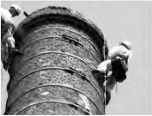
Рис. 3. Обстеження труби альпіністами / Inspection of pipe by alpinists
