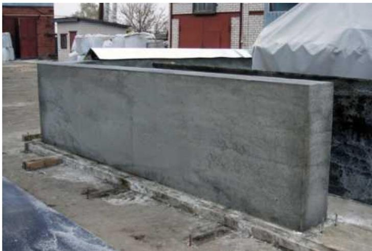
**Рис. 2.** Пример монолитной стены из бетона на основе пеностекла.
