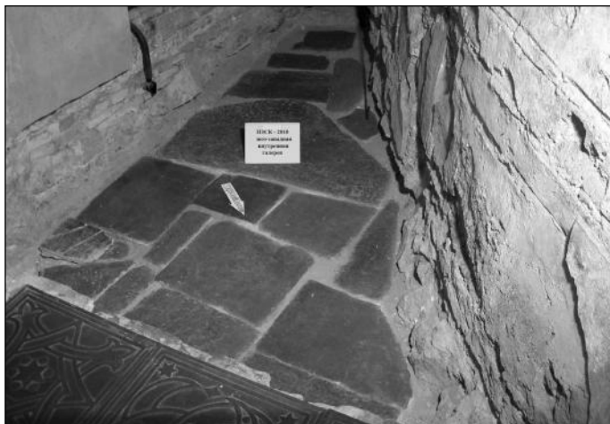
Мал. 1. Зовнішня південно-західна галерея собору. Підлога з шиферних плит
