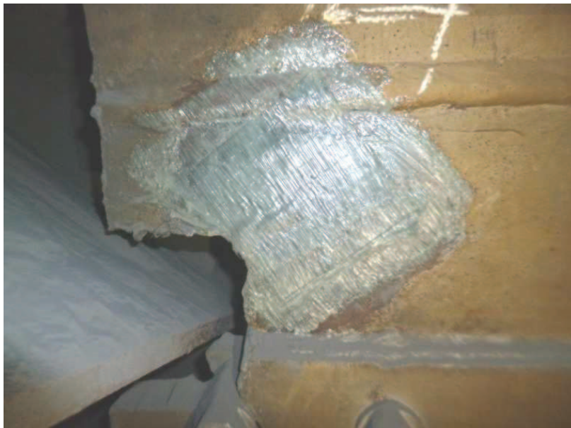
Рис.8 Відремонтована тріщина в корпусі бункера методом консервації
