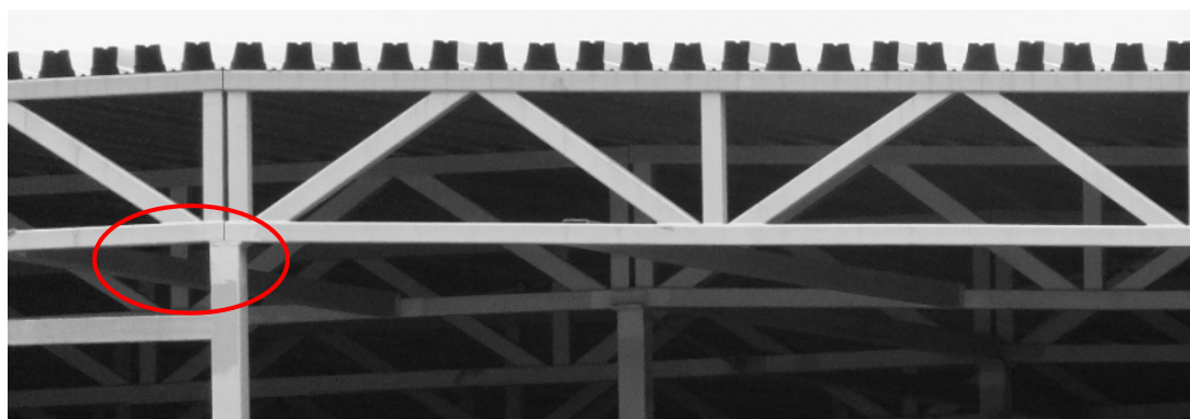
Рис. 2. Применение нетипового опорного узла фермы
