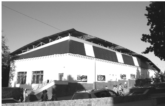
Рис. 4. Загальний вигляд змонтованих конструкцій навісу
