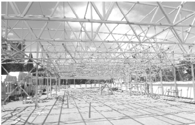
Рис. 3. Загальний вигляд сталевих конструкцій навісу під час монтажу
