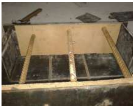
Рис. 2 Фіксація положення арматури перед бетонуванням
