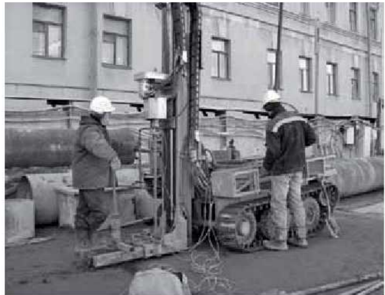
Рис. 2 Погружение зонда на площадке № 3
