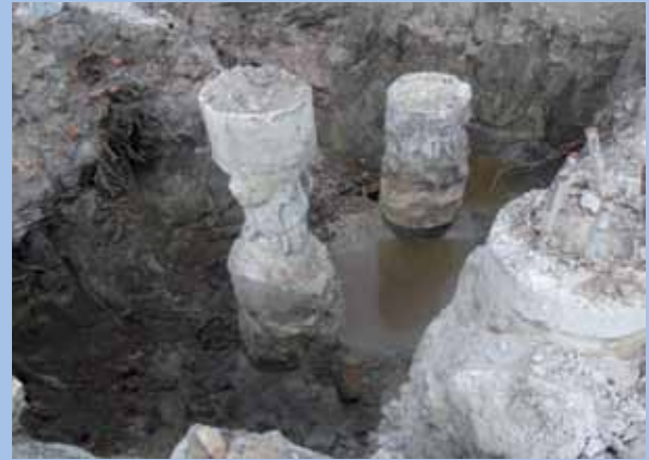
Рис. 7. Уменьшение диаметра свай
