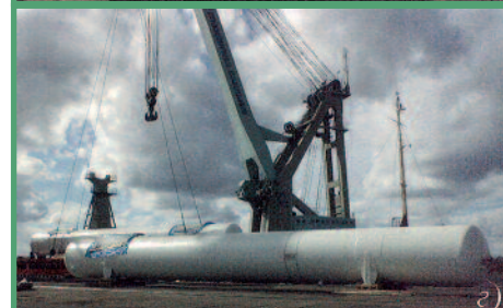
Фото 2. Этапы доставки резервуара РЦГВ-250/0,25: а — установка резервуара на автомобильную платформу; б, в — погрузка его на судно и размещение на палубе для морской доставки; г — вид резервуара после выгрузки в порту
