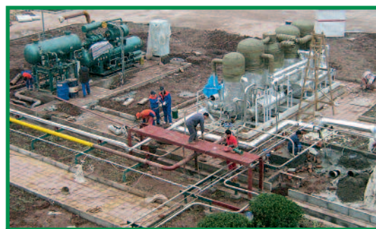
Фото 2. Вид монтажной площадки в районе г. Чунцин (КНР), на которой размещены блок ожижения и холодильная машина СПГ-установки
