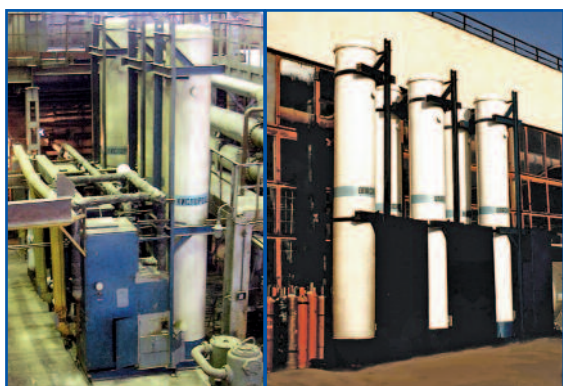
Фото 6. Адсорберы для извлечения криптоноазотной и ксеноноазотной смесей
