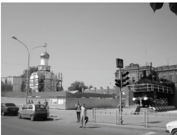
Рис.3. Современный облик Привокзальной площади Таганрога
