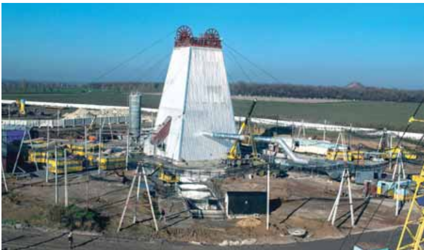
Рис. 1. Оснащенный к проходке воздухоподающий ствол № 3. Июнь 2013 г.
