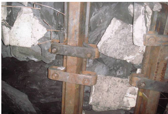
Рис. 3. Состояние замковых соединений крепи выработки, оснащенных стабилизаторами, после прохода лавы.
