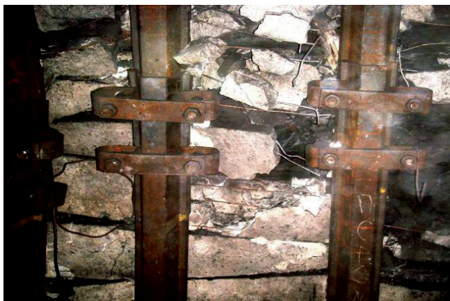
Рис. 2. Положение и взаимная ориентация замков АПЗ.030 и стабилизаторов АЗ 22.02.001 в конвейерном штреке после монтажа.
