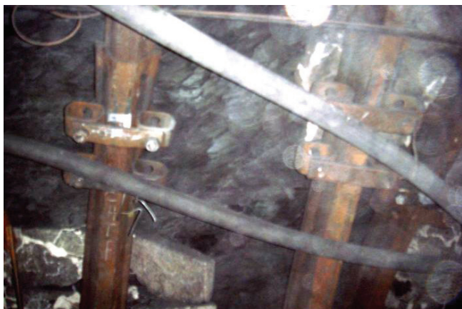
Рис. 3. Состояние замковых соединений крепи выработки, оснащенных стабилизаторами, после прохода лавы.
