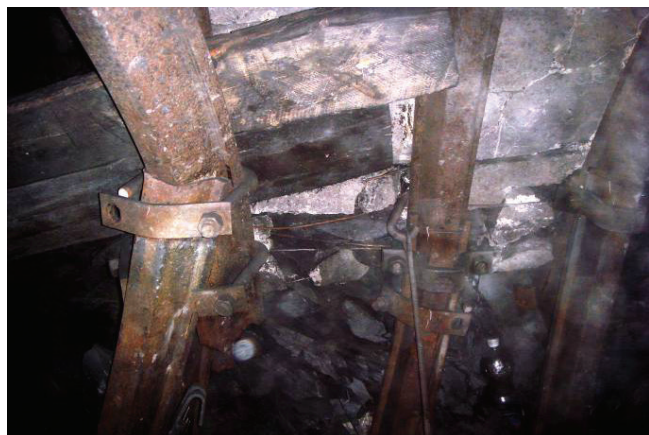
Рис. 5. Состояние замковых соединений крепи конвейерного штрека на контрольном участке после прохода лавы.
