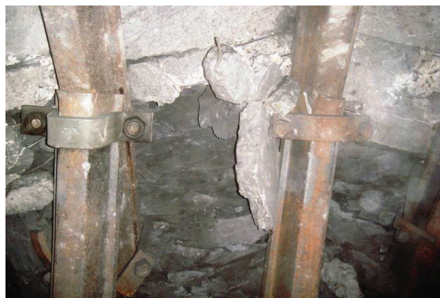
Рис. 5. Состояние замковых соединений крепи конвейерного штрека на контрольном участке после прохода лавы.
