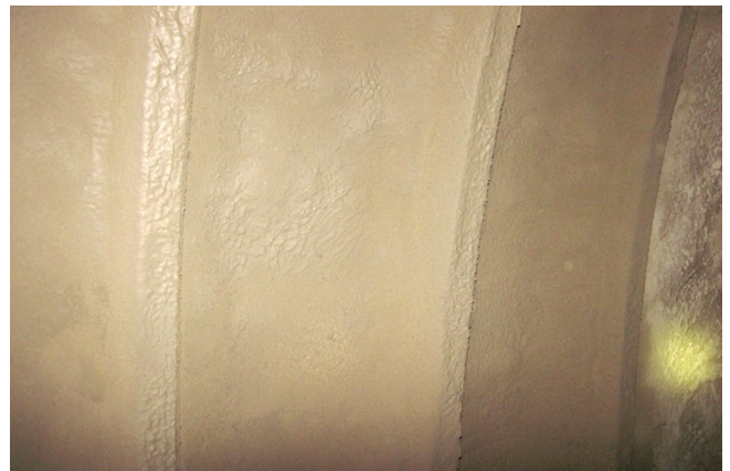
Рис. 4. Вид торкрет-бетонного покрытия на основе использования измельченной породы.
