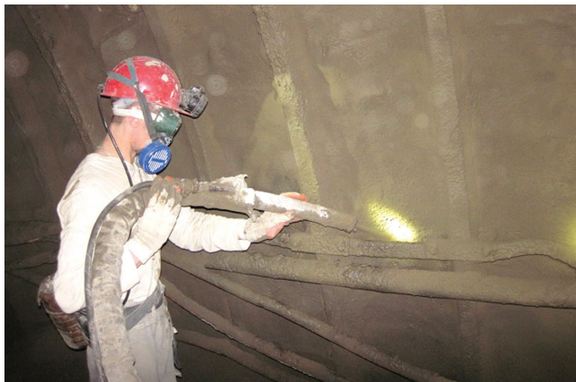
Рис. 3. Процесс нанесения торкрет-бетонного состава с породным заполнителем.
