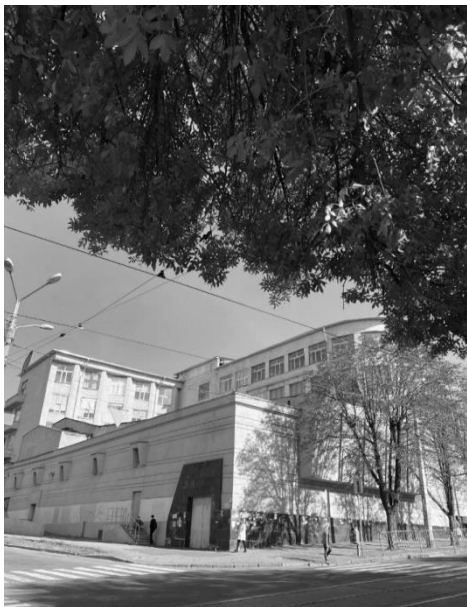
Рис. 6. Фрагмент облицювання лабрадоритом зовнішньої частини актового залу академії
