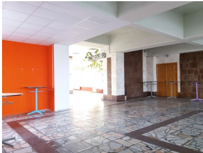
Рис. 12. Туф в облицюванні стін старого корпусу академії
