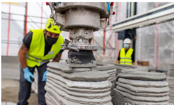
Рис. 3. Процес укладання матеріалу 3D-принтером
