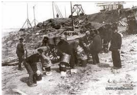
Рис 1. Виконання земляних робіт вручну
