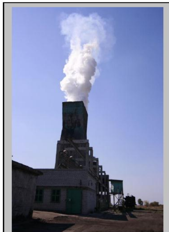
Башня тушения конфузорно-диффузионного типа
