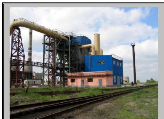
Установка беспылевой выдачи кокса
